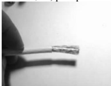
Для удобства монтажа скрутите оплетку. Излишки фольги и оплетки, выступающие из-под разъема можно срезать ножом. Старайтесь не повредить при этом изоляцию. Центральная жила должна выступать из разъема на расстояние от 2 до 5 мм. Отрежьте ее с помощью монтажного инструмента.
